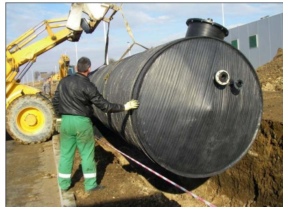
Polaganje glavnog rezervoara individualnog vodovodnog sistema BS "Intermol" u Preševu
